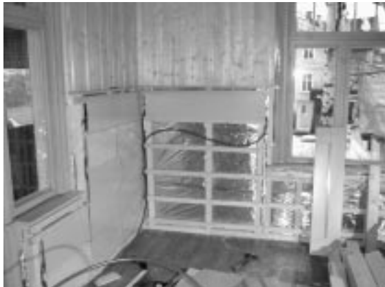
Fig. 7.2.1. Vegger med brystningsvegger på en eller begge sider. Brystningsveggen kan utføres med spalter oppe og nede for øke varmeavgivelsen. Veggvarmeanlegg mot yttervegger tilleggisoleres med minimum 50 mm isolasjon. For uventilerte yttervegger kan tilleggisolasjonen dekket med Al-folie som tjener som diffusjonssperre og reflekterende sjikt.
