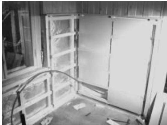
Fig. 7.2.1. Vegger med brystningsvegger på en eller begge sider. Brystningsveggen kan utføres med spalter oppe og nede for øke varmeavgivelsen. Veggvarmeanlegg mot yttervegger tilleggisoleres med minimum 50 mm isolasjon. For uventilerte yttervegger kan tilleggisolasjonen dekket med Al-folie som tjener som diffusjonssperre og reflekterende sjikt.
