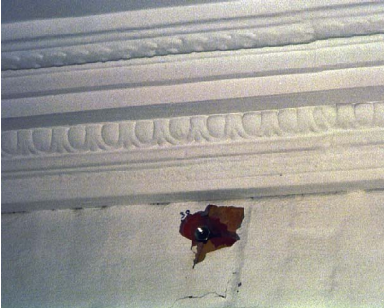
Bilde 9.4.4: Eksempel på hulltaking i murvegg under stukkaturlist.
