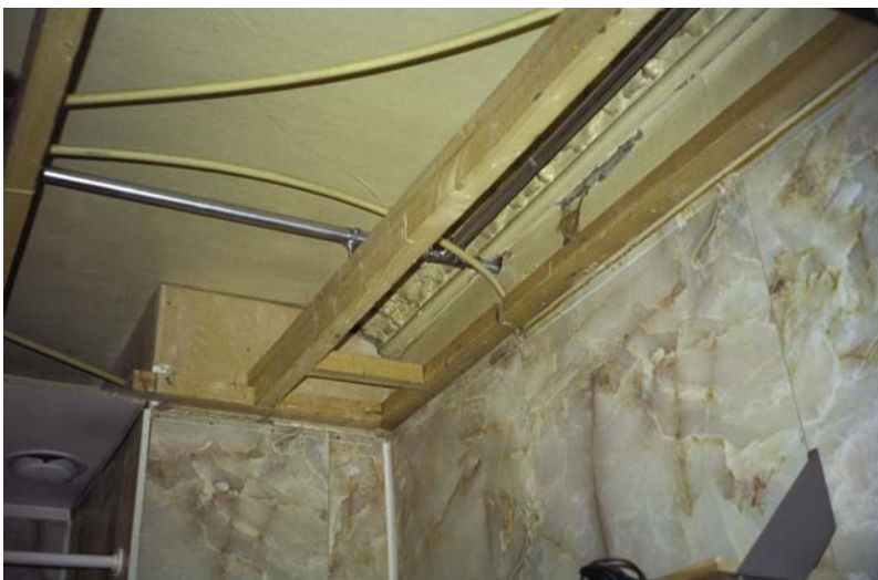
Bilde 9.4.3: Eksempel på fjernet himling i bad for fremføring og fordeling av sprinklerrør til andre rom.
