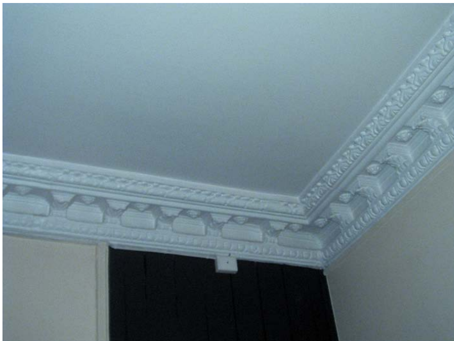
Bilde 5.1.2 a: Stue hvor opprinnelig himling og stukkaturlistene er bevart.
