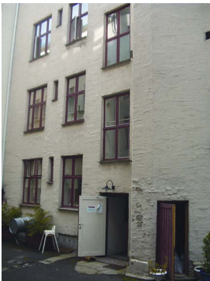
Bilde 5.1.1: Baksiden av forgården (gårdsromsfasaden) – med inngang til trapperom.
